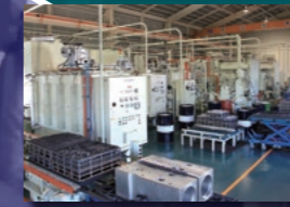
開発工場真空浸炭熱処理設備
